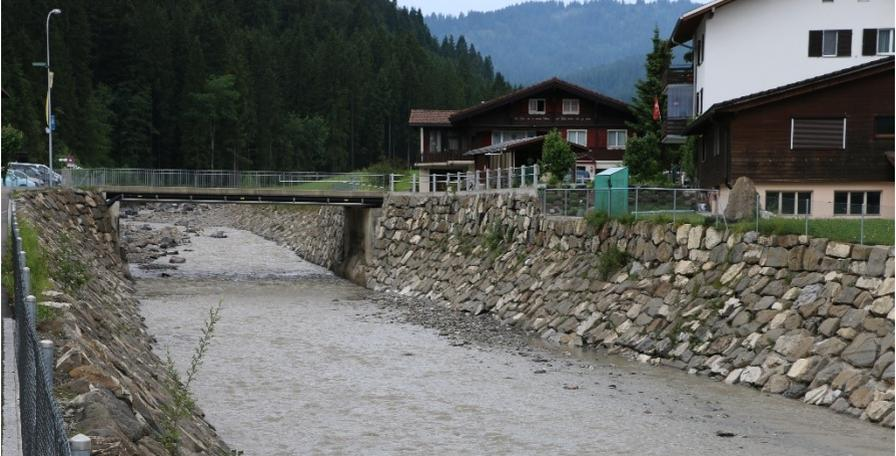
Die Hochwasserschutzmassnahmen zum Schutzes des Dorfes Unterberg funktionierten wie geplant. Die grossen Wassermassen der Minster konnten das Dorf Unterberg gefahrlos passieren. Der Hartverbau durch das Dorf Unterberg bewährte sich hervorragend.
