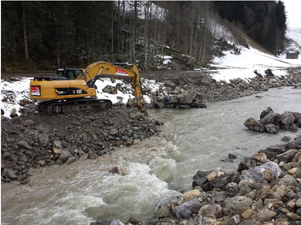
Rückbau Baupiste in Bach, Erstellung Sohlenbelegung
