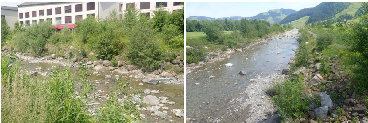
Tab. 5.20: Rähnenverbau als Schutz vor Verdriftung im Hochwasserfall und abwechslungsreicher terrestrischer Lebensraum an der Minster im Projektzustand
