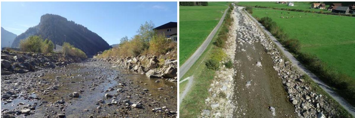
**Abb. 6.3: Die fehlende Niederwasserrinne führt zu geringer Wassertiefe und eingeschränkter Durchgängigkeit** im Projektzustand 2018
