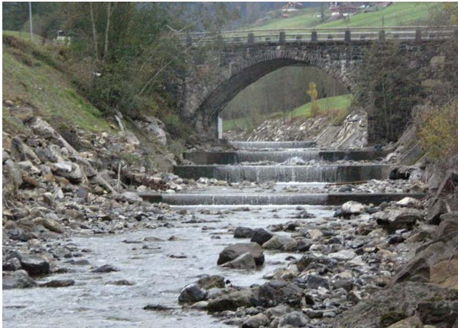
Insgesamt fünf, teilweise hohe Sperren bei der Jässenenbrücke wurden durch eine gesetzte, strukturierte Blockrampe ersetzt (Abb. 6.2). Dadurch sollte die aquatische Längsvernetzung in der Minster zwischen der Mündung Surbrunnensbach und dem Zusammenfluss mit der Waag wiederhergestellt werden.
