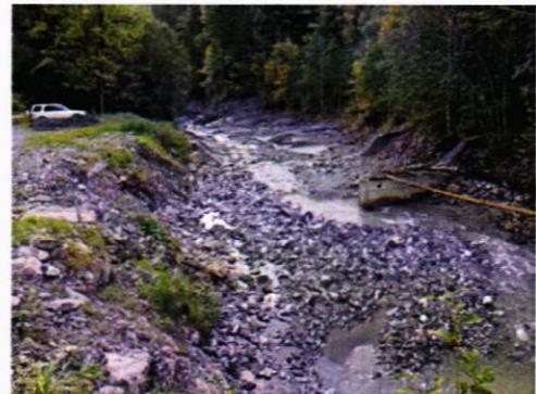
Abb.10: Zerstörte Sperre und beschädigtes Ufer
