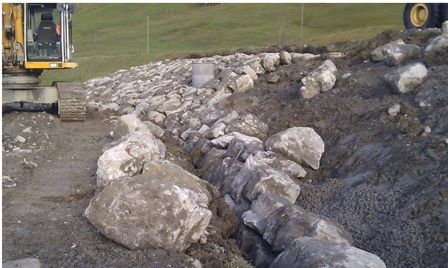
Ausleitung Nidlaubach: Fussstein in Geröllbeton versetzt.
