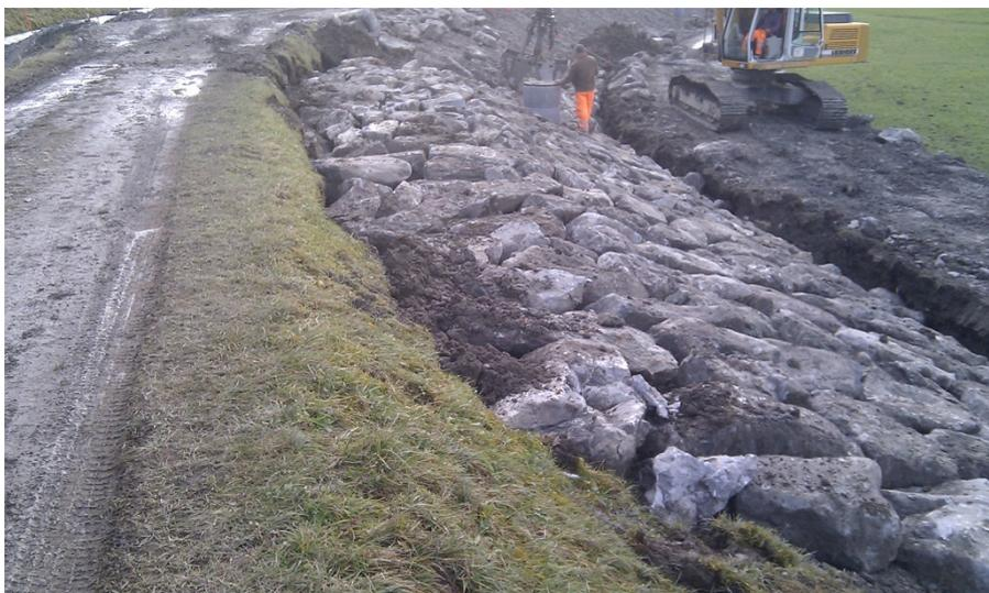
Ausleitung Nidlaubach: Blockbelegung der luftseitigen Böschung.
