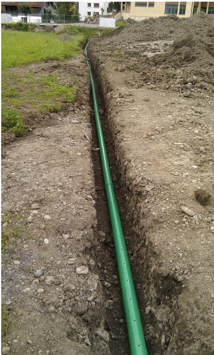
Sickerleitung am Fusse Schutzdamm Minster
