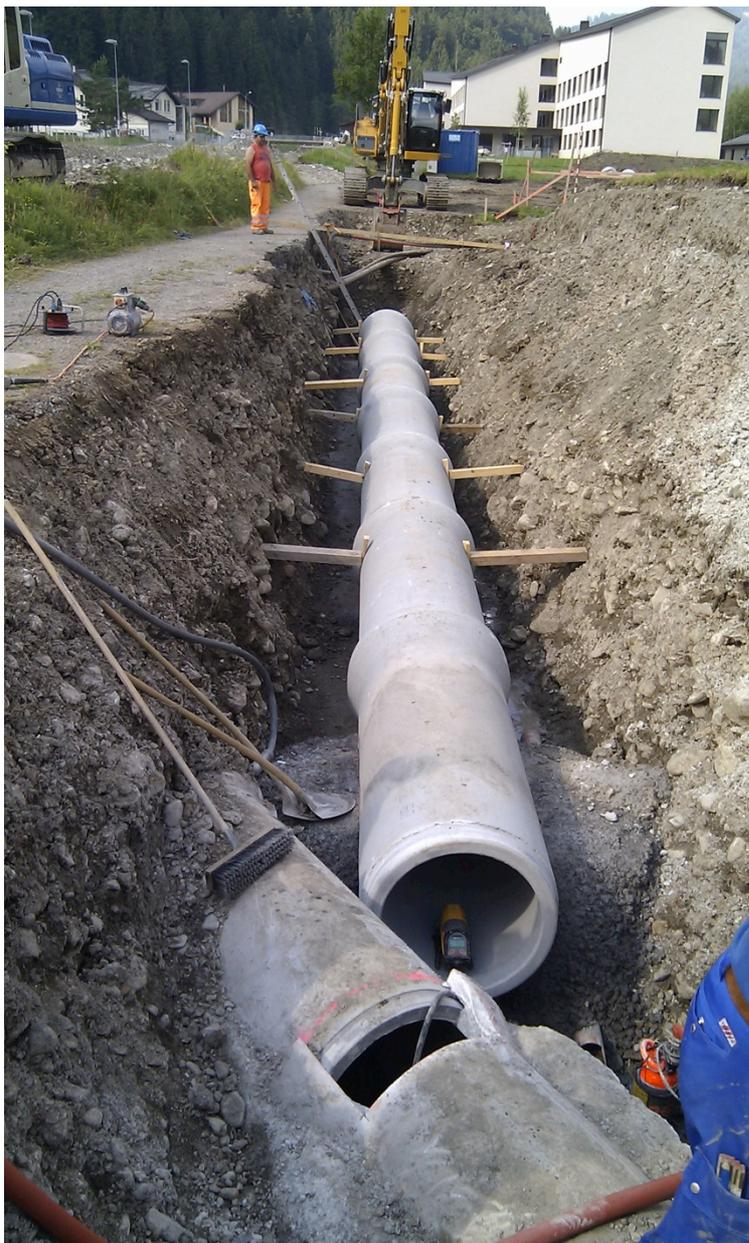
Verlegung der Schmutzwasserleitung bei Schelbert
