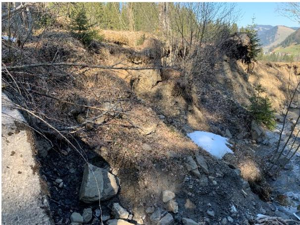
Abbildung 4: Erodirtes Ufer und Rutschungen im Bereich der Kurve
