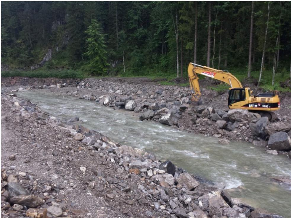
Umlegung Baupiste auf rechte Uferseite, Erstellung Rähnenverbau rechtes Ufer bis Los 1
