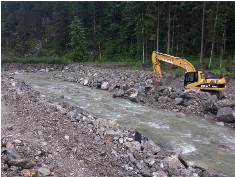
Umlegung Baupiste auf rechte Uferseite, Erstellung Rähneverbau rechtes Ufer bis Los 1
