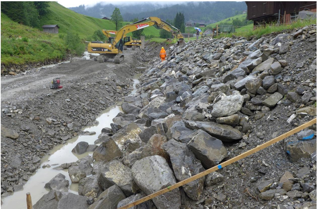
Übergangsbereich zum Blocksatz in Beton bei Jauchegrube
