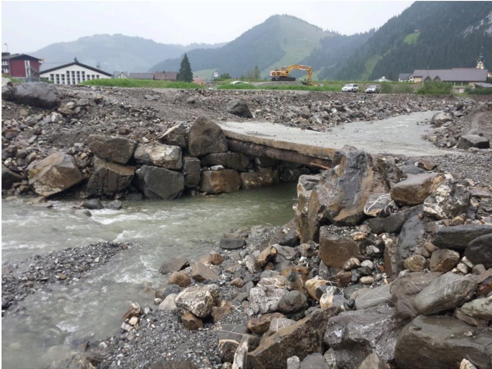
Provisorische Brücke aus Baumstämmen und einer Betonplatte für Transporte innerhalb der Baustelle
